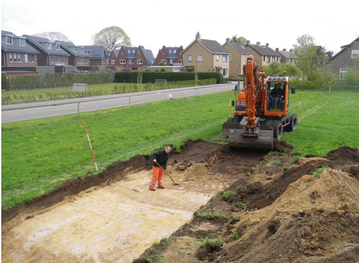
Afbeelding 1.2: Aanleg van het vlak in één van de proefsleuven (werkput 4).
